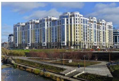
г. Екатеринбург, ЖК Клубный Дом Ривьера АРМ «Ресурс» 3610 ПУ
